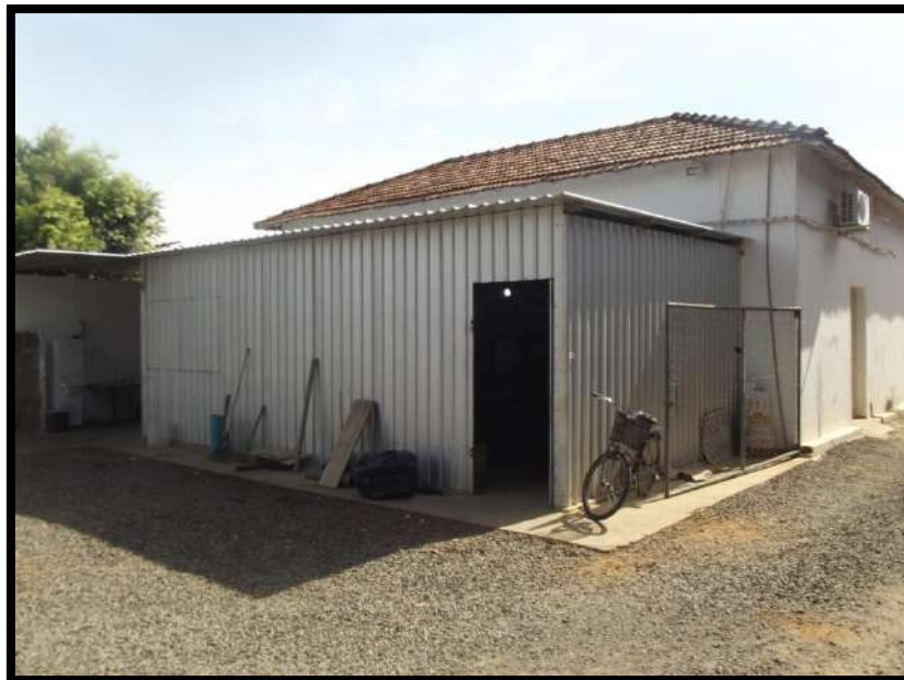
Barracão de armazenamento temporário resíduos eletrônicos
