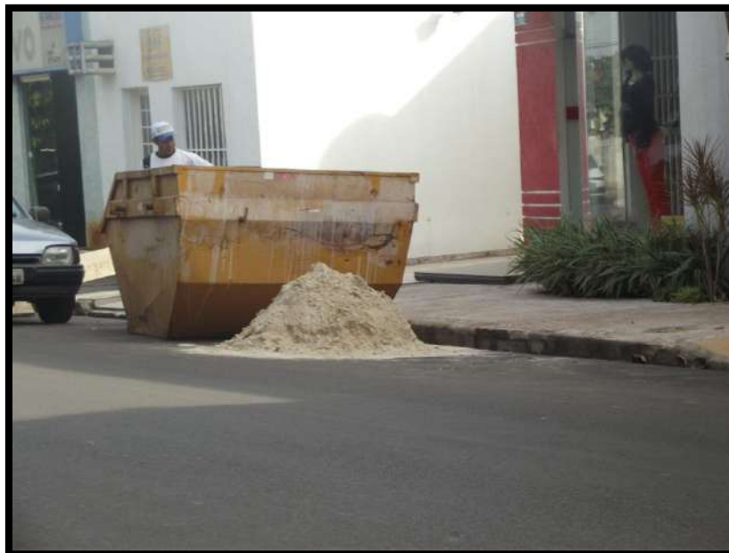
Acondicionamento dos Resíduos da Construção Civil
