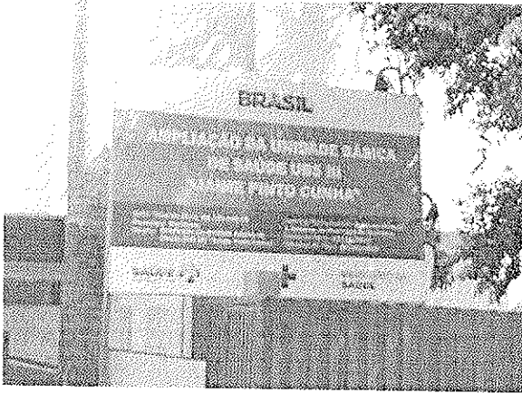
Placa de Identificação da obra:
