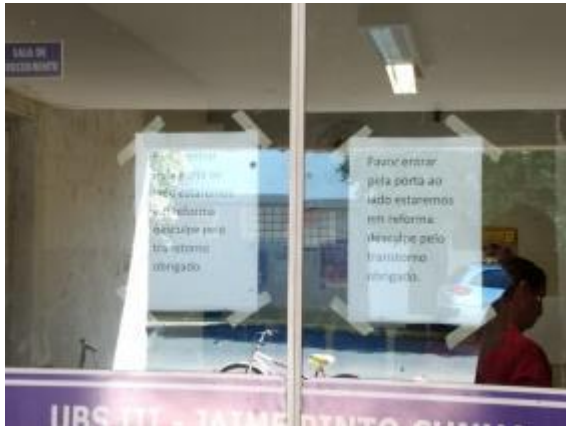
Acesso à farmácia obstruída:
