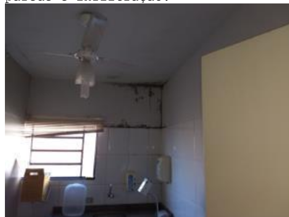
Sala de Curativo com azulejo em meia parede e infiltração:
