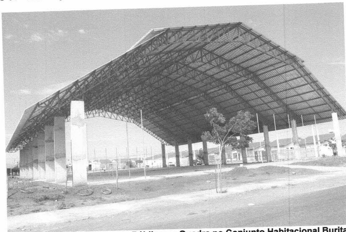
FOTO 01 – Realização do Passeio Público na Quadra no Conjunto Habitacional Buritama G
