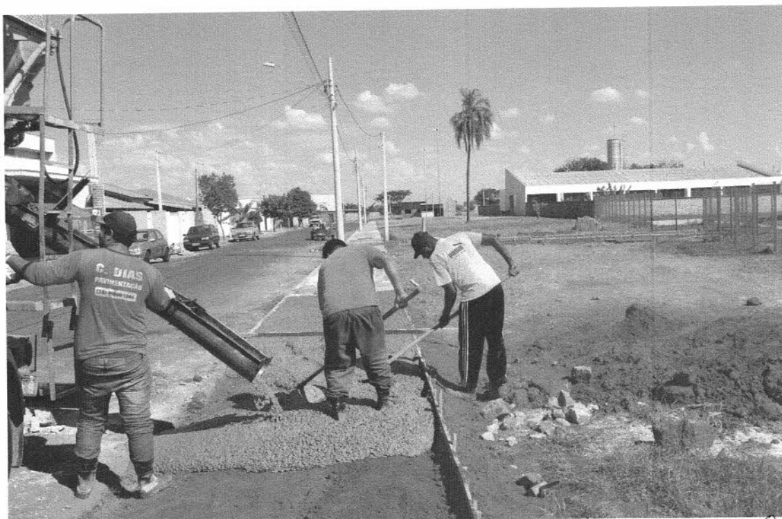
FOTO 10 – Processo de concretagem do passeio público na Escola Profª Maria Aparecida Duarte.
