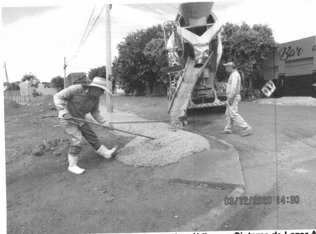
FOTO 24 – Processo de concretagem de passeio público no Sistema de Lazer Aparecido Rodrigues Moutinho – Rua Joaquim Dias Salles.
