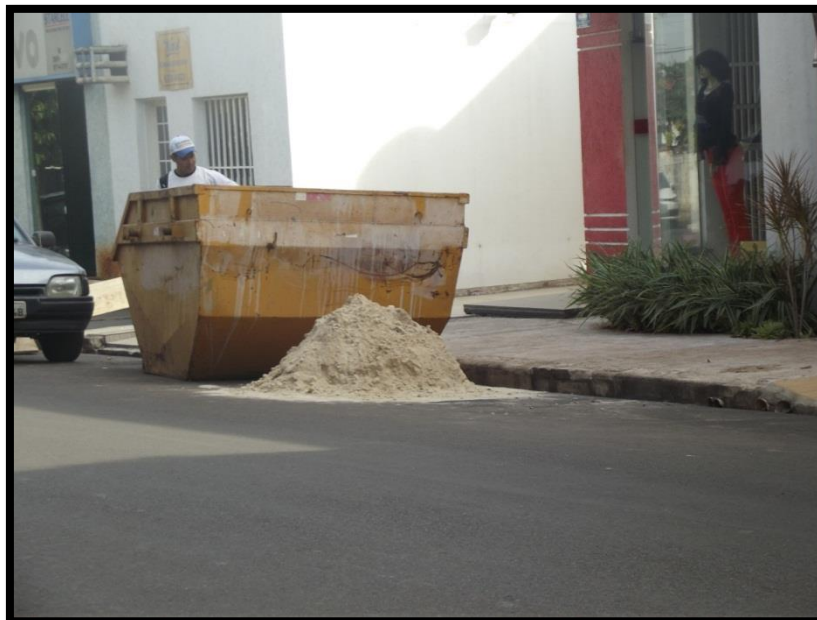
Acondicionamento dos Resíduos da Construção Civil
