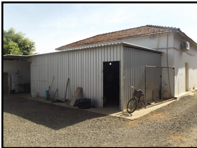
Barracão de armazenamento temporário resíduos eletrônicos
